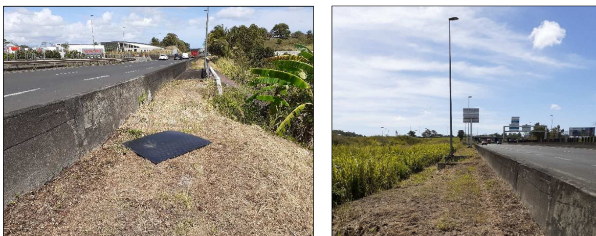
Figure 24 : Aperçus de la station 2 peu de temps après le passage de l'épaveuse
